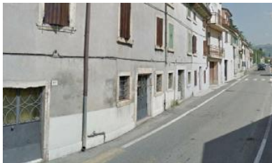
Una parte del tratto della via interessato ai lavori
